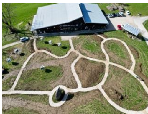
Photo 47 : Travaux des aménagements extérieurs
